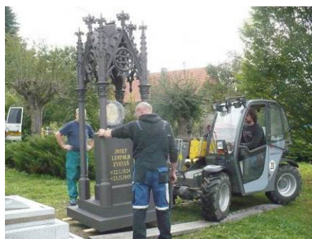
2014 rekonstrukce pomníku J.L.Zvonaře
