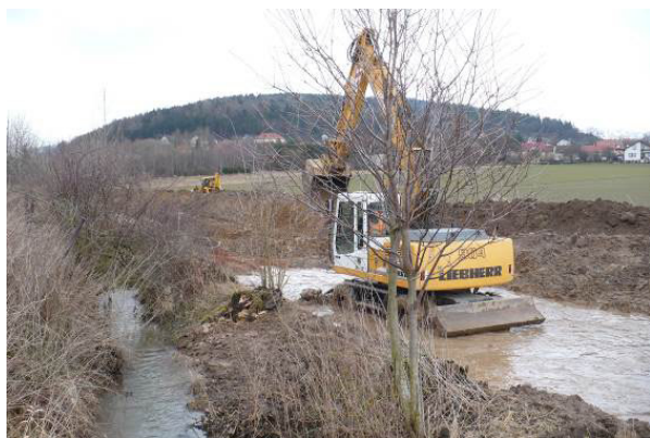
2009 Začátky stavby kanalizace nebyly lehké
