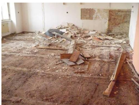
2013 celková rekonstrukce MŠ s výměnou oken a kotle, instalace podlahového topení, zateplení
